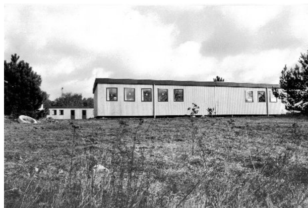
Nødgymnasiets bygninger ved Helsingør Teknikum 29.10.1978 Foto: Anne Sofie Rubæk Hansen, Frederiksborg Amts Avis
